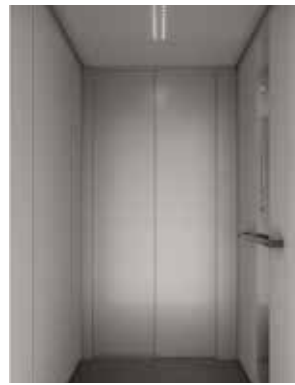
Vegger: Folkstone laminat, matchende profiler i RAL 830. Gjennomgang med hvit dør. Kontrollpanel: rustfritt stål. Tak med LED-lys: RAL 830.
